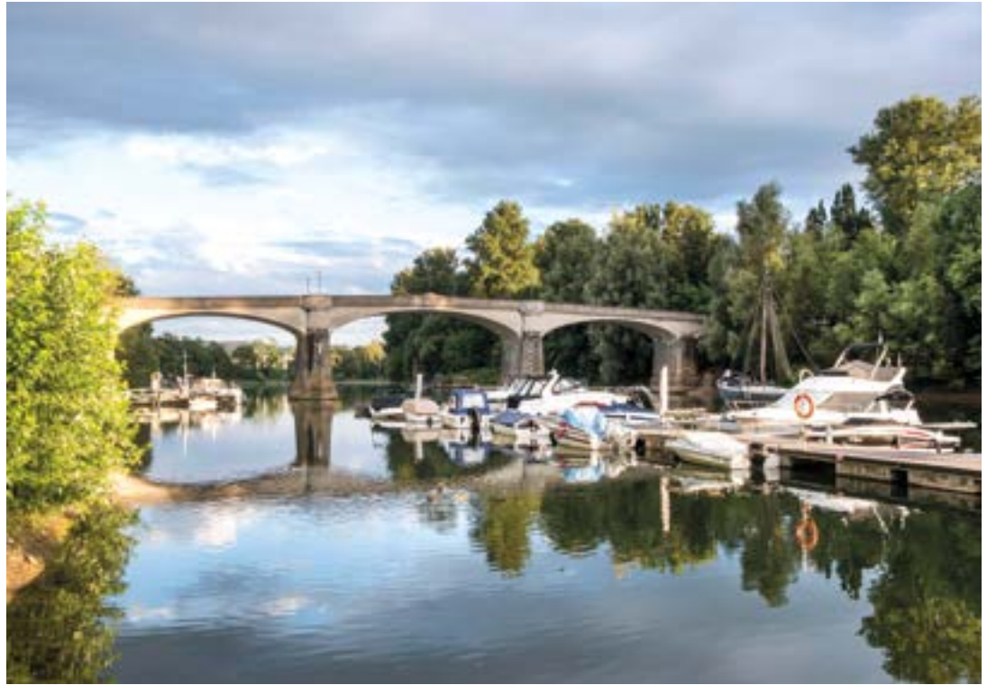
Die sanierte Steganlage am Südsteig | Bild: Archiv WSVH
