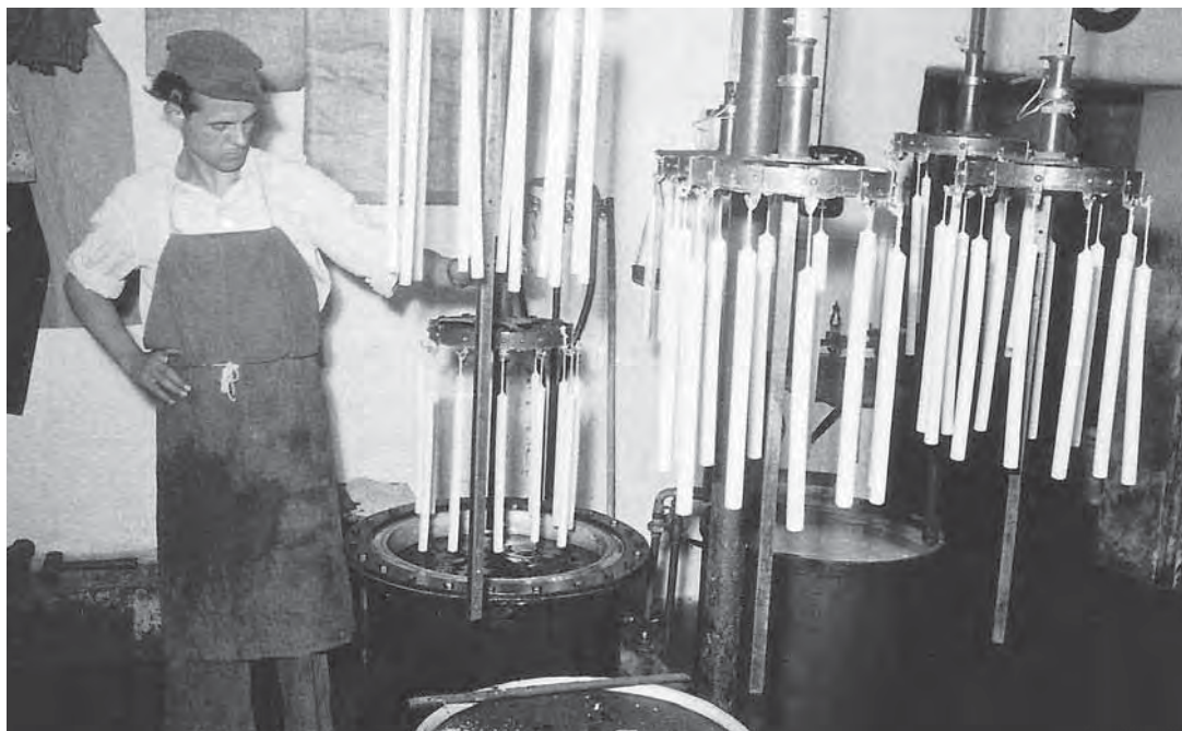
Durch das Tauchbad erhalten die Kerzen einen härteren Mantel
