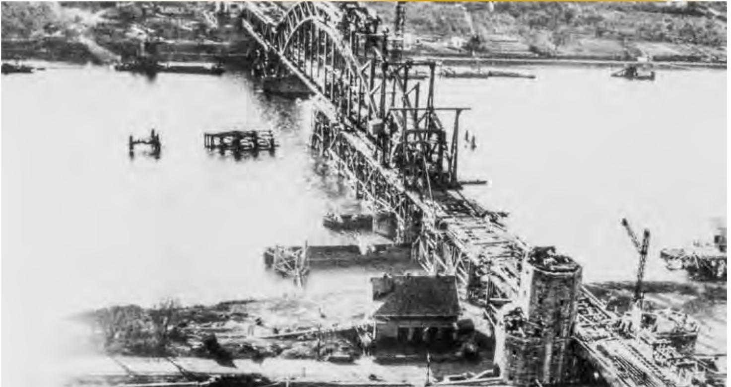
**Blick von der Erpeler Ley auf die im Bau befindliche Ludendorffbrücke. Die Brücke hatte eine Gesamtlänge von 325 und im Mittelbogen eine Höhe von 30 m. 4.642 t Stahl wurden für den Bau benötigt. | Bild: ad Erpelle**
