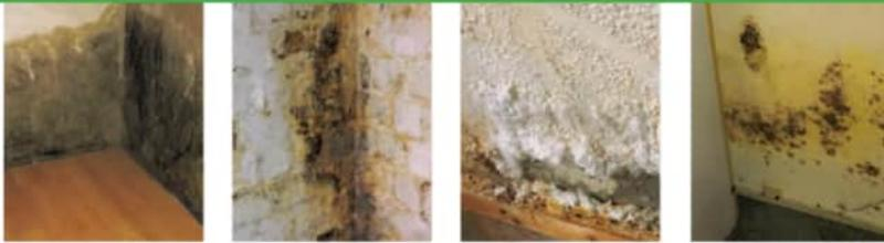
Defekte Horizontalsperre      Querdurchfeuchtung      Ausblühungen      Schimmelbefall
