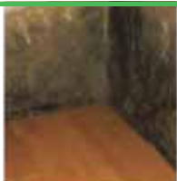
Defekte Horizontalsperre
