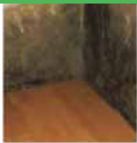
Defekte Horizontalsperre
