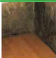
Defekte Horizontalsperre
